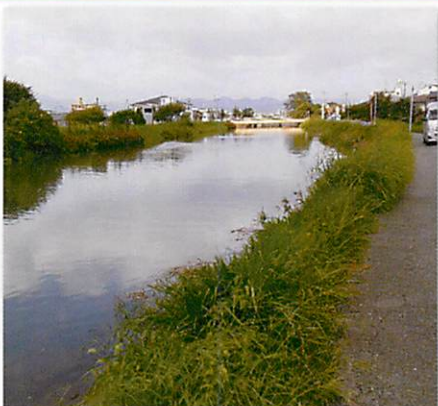
2013年9月台風18号被害時の西高瀬川
